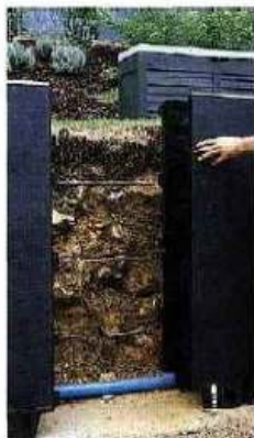
Les parois modulaires sont disposées autour du futur bassin.
