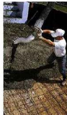
Le coulage du radier se fait à la suite du remplissage des murs.
