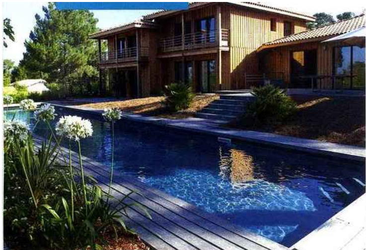
Un escalier maçonné en angle intérieur et un liner noir équipent ce bassin, style couloir de nage. La profondeur va de 1,2 à 2 m. Avec volet immergé. Réalisation Carré Bleu Agretec (33 Artigues). Carré Bleu
