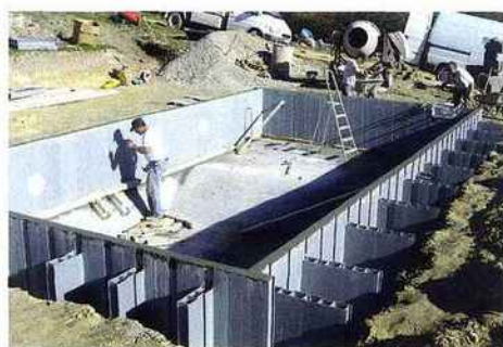
La structure est maintenant entièrement montée, en attente de la pose de la membrane armée. La disposition des jambes de force permet de réaliser l'assise d'une plage béton, sans risquer les effets de tassement d'un remblai enterré.
