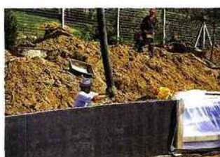
... suivi par le coulage du béton.
