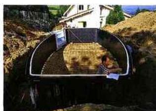
On procède à l'assemblage de la structure...
