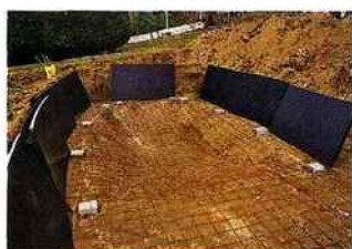
Après la pose d'un treillis soudé pour "armer" le futur radier béton et la mise en plan (à niveau) de dalles à la jonction des panneaux.
