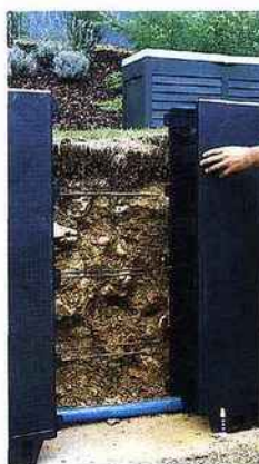
Les parois modulaires sont disposées autour du futur bassin.
