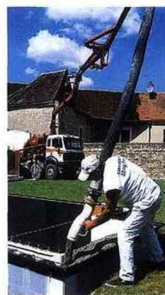
Le coulage du béton se fait en effectuant 2 ou 3 passages pour équilibrer les pressions dans les panneaux.
