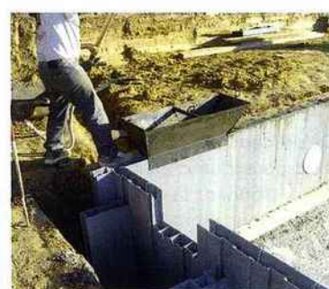
On procède alors au remplissage des éléments PVC. Le coulage du béton est facilité par la mise en place d'une goulotte d'injection. On observe au 1 er plan la découpe servant de réservation pour la pose d'un skimmer.
