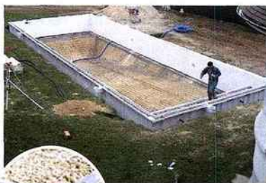
Les poteaux et la ceinture sont prêts à recevoir les armatures métalliques de maintien.
