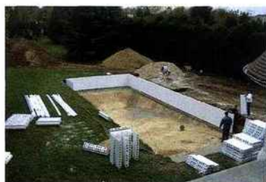
Les éléments sont assemblés entre eux par simple coulissage. Ils prennent place sur une semelle béton.
