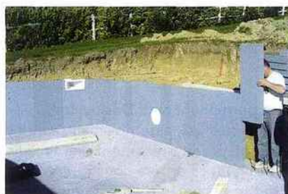
Les éléments s'assemblent en coulisant les uns dans les autres.
