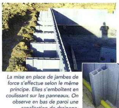
La structure est maintenant entièrement montée, en attente de la pose de la membrane armée. La disposition des jambes de force permet de réaliser l'assise d'une plage béton, sans risquer les effets de tassement d'un remblai enterré.
