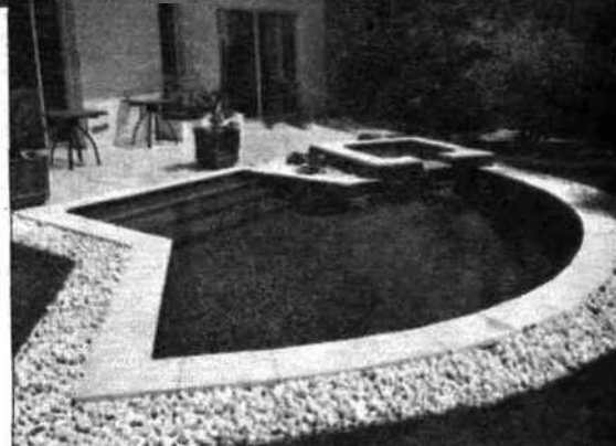
Petite piscine de forme libre construite en béton armé (Gunité) avec un revêtement Crystalroc gris. Équipée d'un spa. Diffazur.
